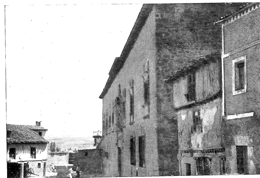
Fot. 2. — Palacio de Avellaneda, en reparación (Peñaranda).
